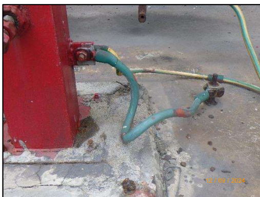
รูปที่ 3-48 ระบบสายดินบริเวณกักเก็บก๊าซไฮโดรเจน
