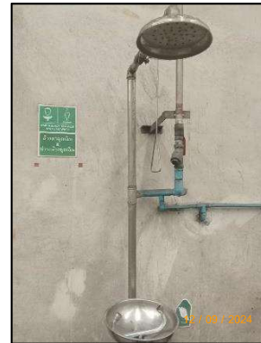
รูปที่ 3-29 อ่างล้างตาและฝักบัวฉุกเฉิน
