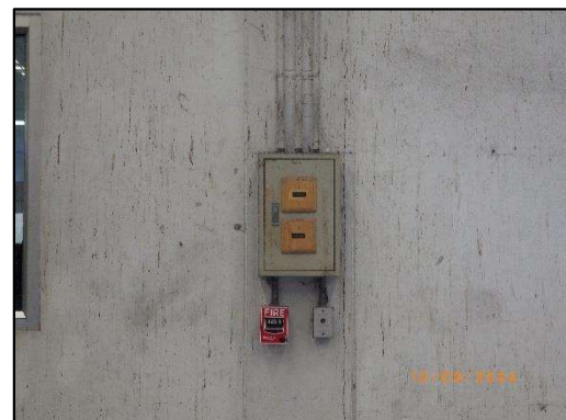
รูปที่ 3-44 สัญญาณแจ้งเหตุไฟไหม้ (Fire Alarm)
