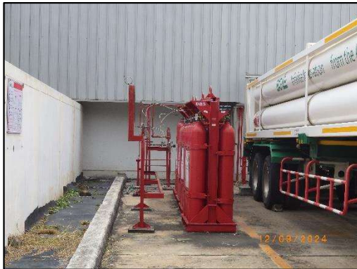
รูปที่ 3-45 การจัดเก็บก๊าซไฮโดรเจน และก๊าซไฮโดรเจนสำรองในพื้นที่ที่มีอากาศถ่ายเท
