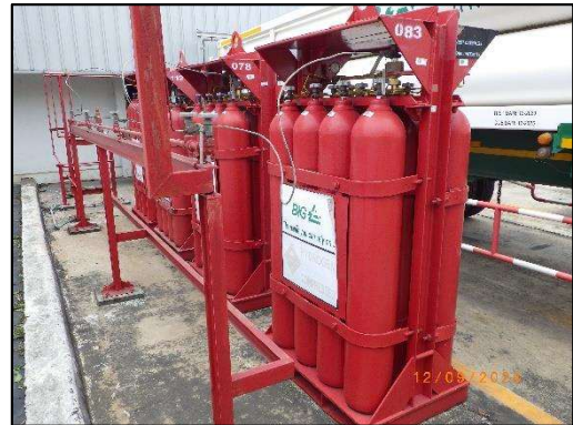
รูปที่ 3-45 การจัดเก็บก๊าซไฮโดรเจน และก๊าซไฮโดรเจนสำรองในพื้นที่ที่มีอากาศถ่ายเท
